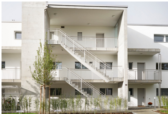
Abbildung 5 Gerade Treppe als interne Gebäudeerschliessung beim Laubengang
